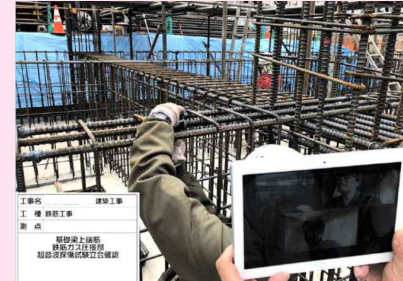
Webカメラを利用した遠隔検査
