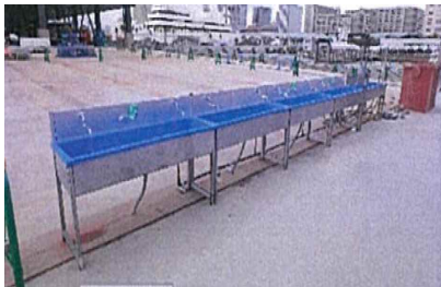
現場の手洗い場所の増設
