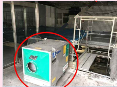
集塵機を設置し室内の換気を実施
